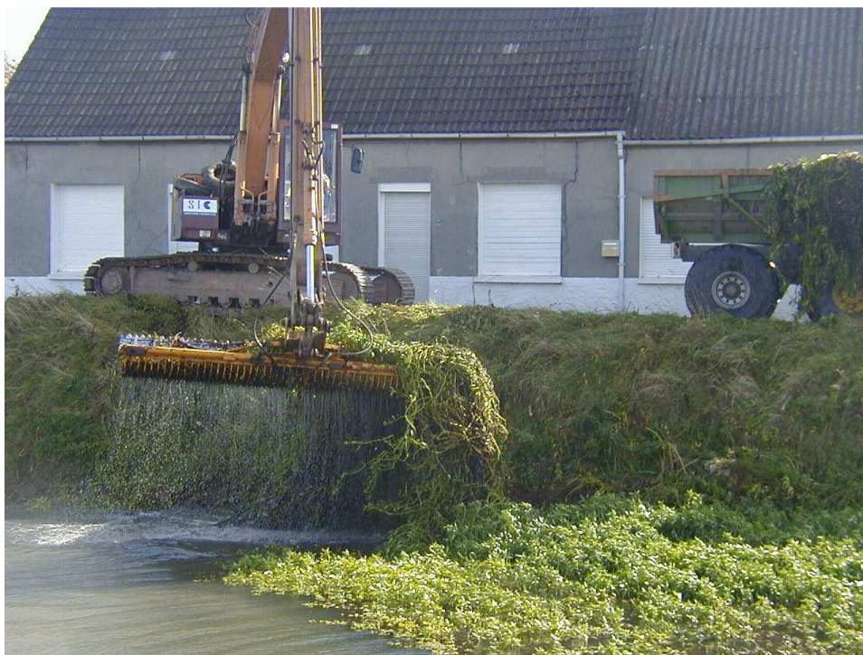
Chantier d'arrachage mécanique de Jussie
